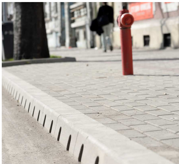
Rys.13. Krawężnik ze zintegrowanym kanałem odwadniającym z polimerbetonu szer. 150mm, wys. 305mm np. Aco Drain wariant podłączenia – tylne przez rewizję pokazano jako przykładowe rozwiązanie .
